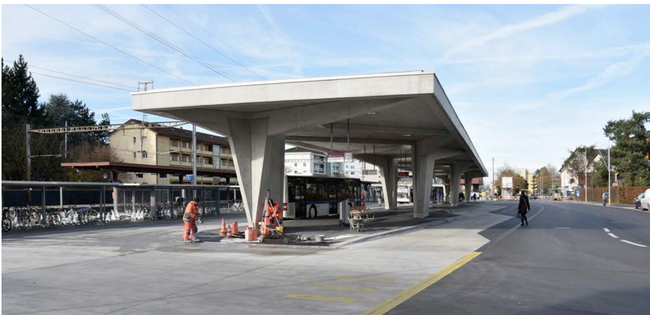
Bushof Bahnhof Schwerzenbach, November 2017
