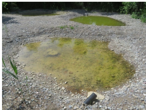
Foto 16: im Vordergrund neues ablassbares Kiesgewässer sowie im Hintergrund zentrales Kiesgewässer im Obj. 1.2, Schützenhaus (Foto vom 14.5.2024).
