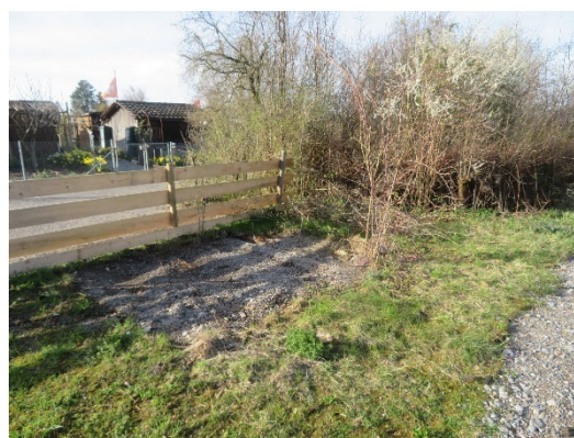
Foto 8: Entferntes Hüttchen und Sicherheitszaun im Obj. 1.2, Schützenhaus (Foto vom 19.3.2024).
