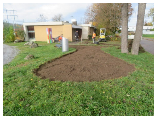
Foto 10: Abschälen Vegetation in artenarmem Wiesenbestand beim Chimlibach/Tennisplatz (Foto vom 15.11.2023).
