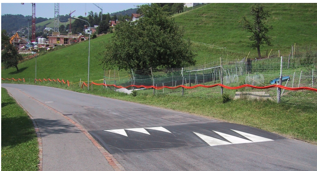
Abbildung 10: Referenzfoto kreissegmentförmiger Vertikalversatz
